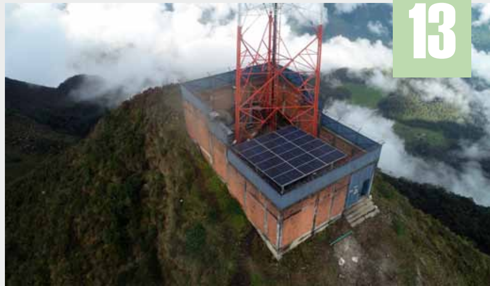
SE INSTALARON paneles solares en 62 estaciones base.
